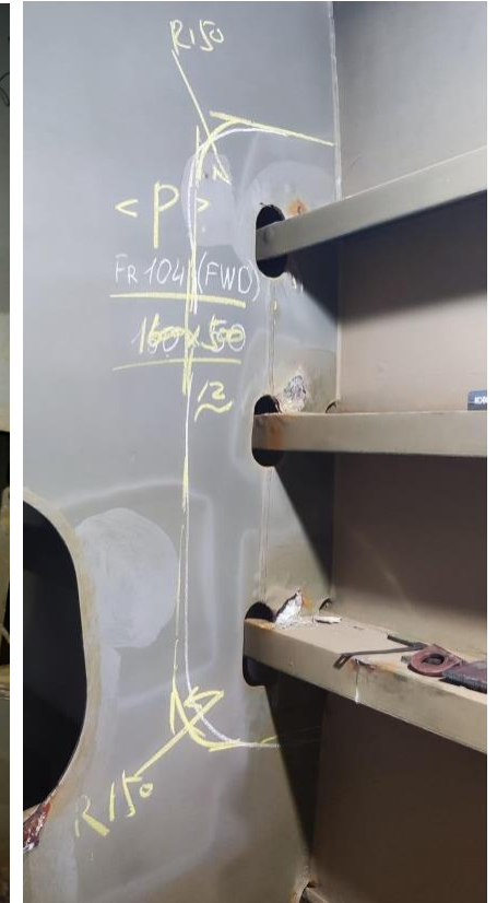
WEB FRAME 104 (BETWEEN STR. NO. 2 & STR. NO. 3 I.W.O. SL-38, SL-38.1 & SL-39)
